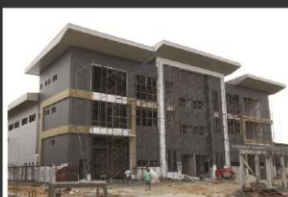
ETP2 建设中 @Meru Industrial Park
