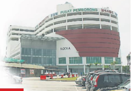
B座的建设工程如火如荼进行中，未来将与A座衔接，打造时装主题的批发中心。
